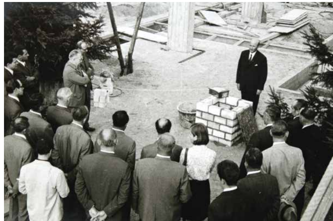
Stein auf Stein: Der offizielle Baubeginn – ebenfalls 1969.
